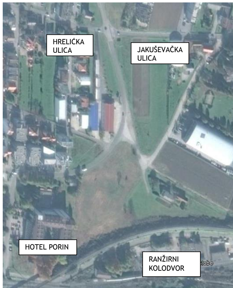
Slika 1.2-1. Sarajevska cesta od križanja s Hreličkom i Jakuševačkom ulicom do Ranžirnog kolodvora - postojeće stanje
